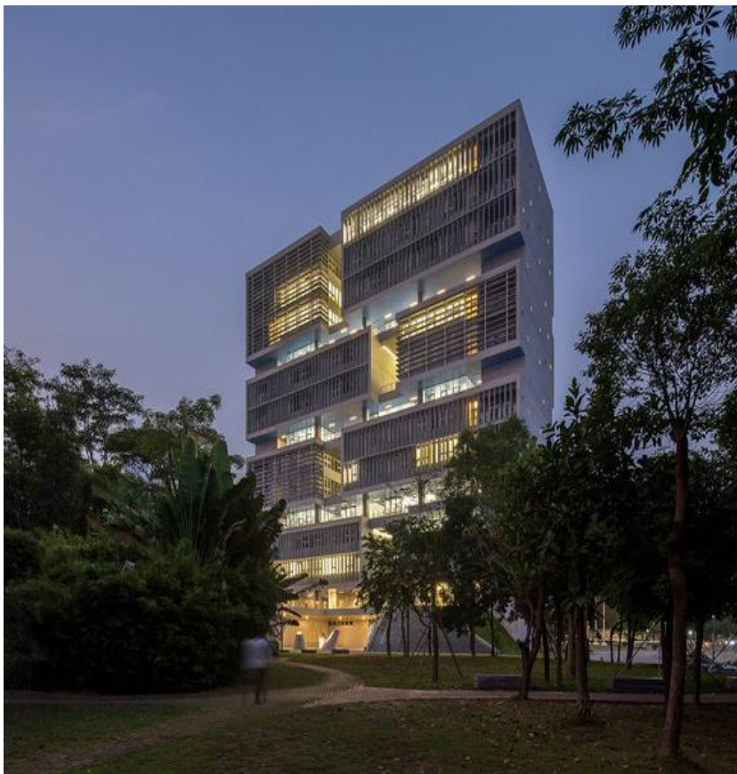
清华大学深圳国际研究生院海洋楼
